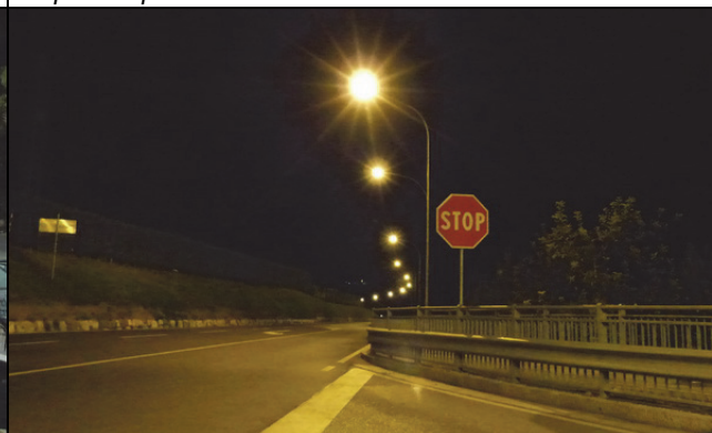
Figura 1.21 – Via Trento da Via Gramsci. Illuminazione adeguata ma fortemente abbagliante.
