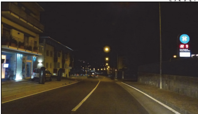
Figura 1.24 – Via Marconi - Illuminazione abbagliante e a ridotto confort visivo – piuttosto inadeguata alle caratteristiche della strada
