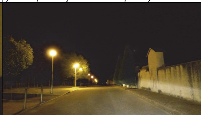
Figura 1.27 – Via Friena Cimitero – Illuminazione abbagliamenti e molesta
