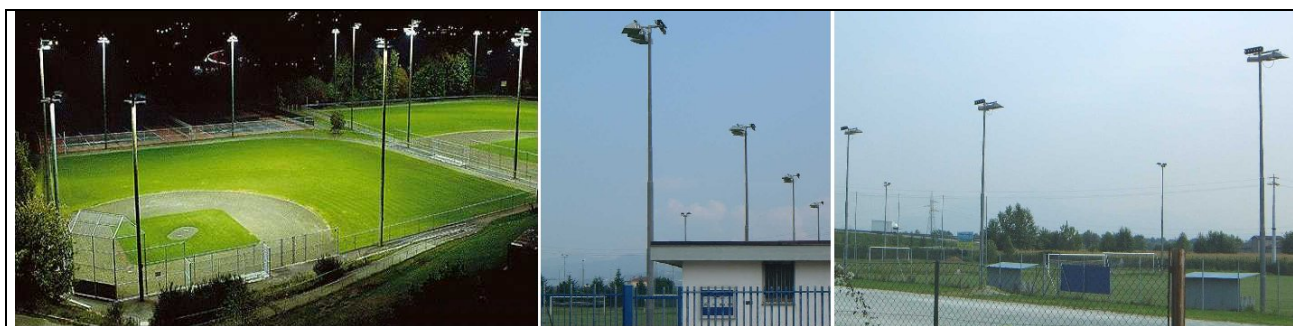
Figura 2.10 - Impianti sportivi illuminati in modo conforme alla L.P. 16/07 con proiettori asimmetrici orientati orizzontalmente e che non disperdono luce verso l'alto.
