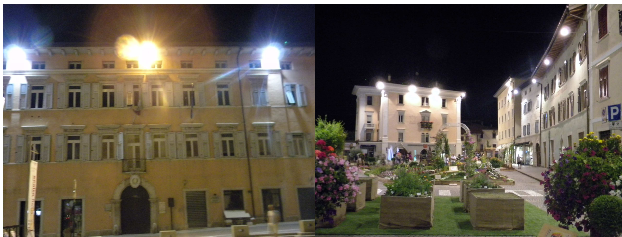
Figura 4 - fotografie notturne con l'effetto di abbagliamento dovuto all'errata inclinazione dei proiettori
