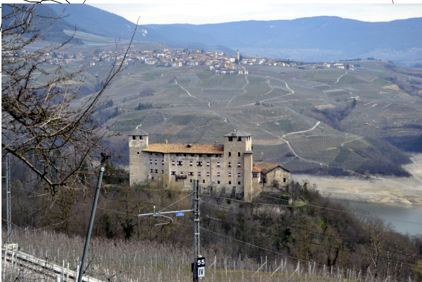
Castello di Clès illuminazione a ioduri metallici 4200 - 4000 gradi kelvin o Led 4200 - 4000 gradi Kelvin Scheda5
