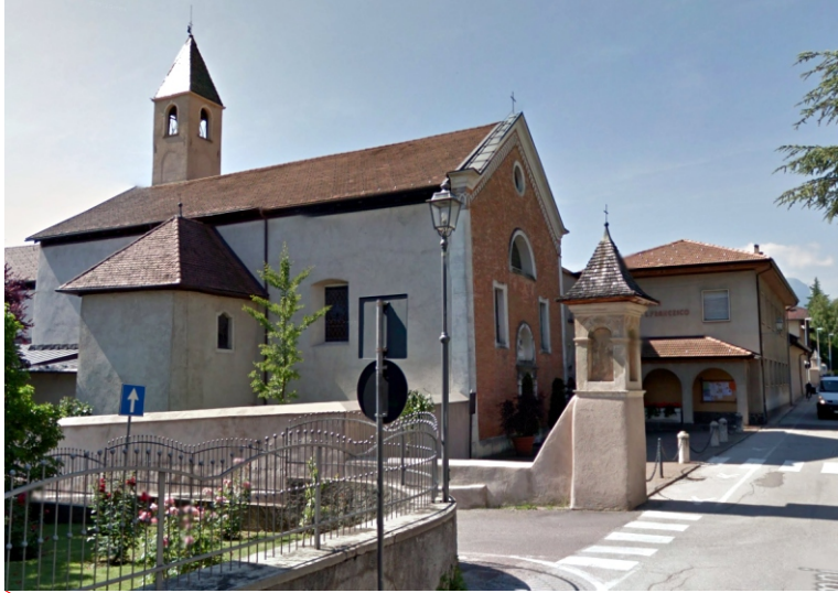
Convento di S. Antonio illuminazione a ioduri metallici 4200 - 4000 gradi kelvin o Led 4200 - 4000 gradi Kelvin Scheda 1
