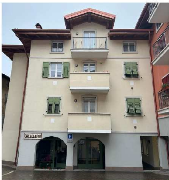
EDIFICIO N°327 - DA R2 A R3
