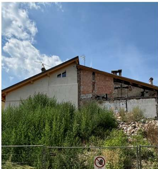
EDIFICIO N°128 - DA R2 A R3
