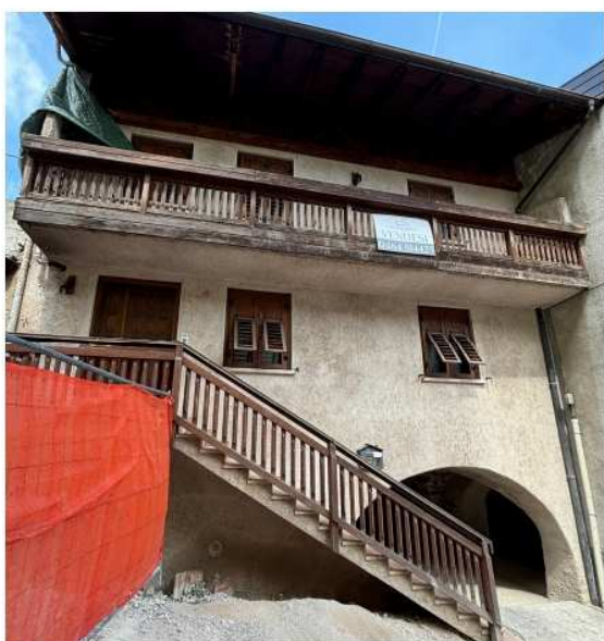
EDIFICIO N°129 - DA R2 A R3
