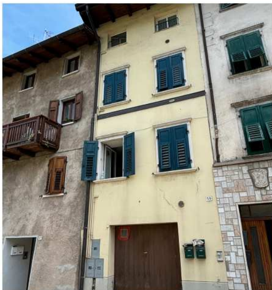
EDIFICIO N°181 - DA R2 A R3
