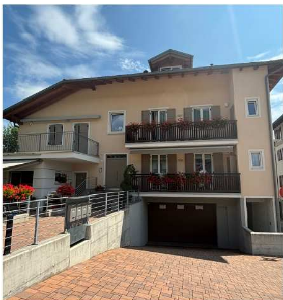
EDIFICIO N°305 - DA R2 A R3
