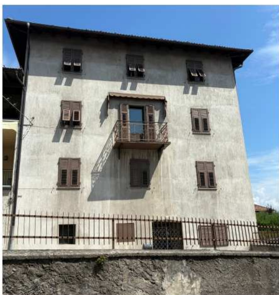
EDIFICIO N°148 - DA R2 A R3
