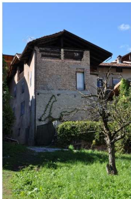
Esempio di fronte da riqualificare
